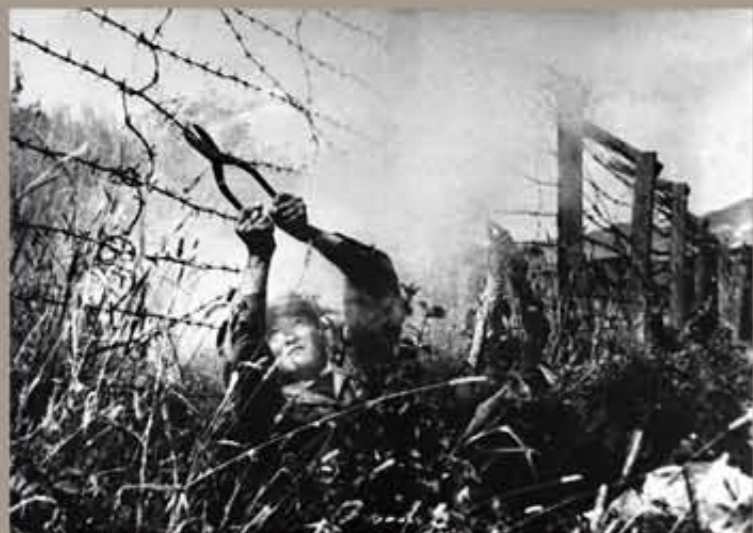
工兵切断铁丝网障碍物，开辟通路。
